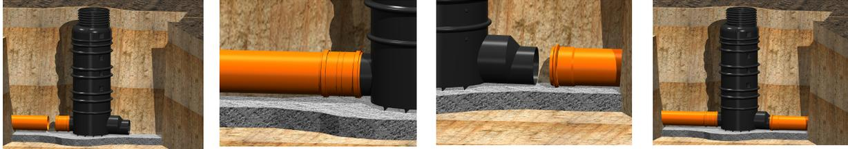
**A continuación, y solo en el caso de pozos de bombeo de cualquier diámetro, se deberá rellenar el fondo interior del pozo con hormigón hasta una altura de 20cm. Este relleno debe realizarse inmediatamente después de nivelar el pozo.**
